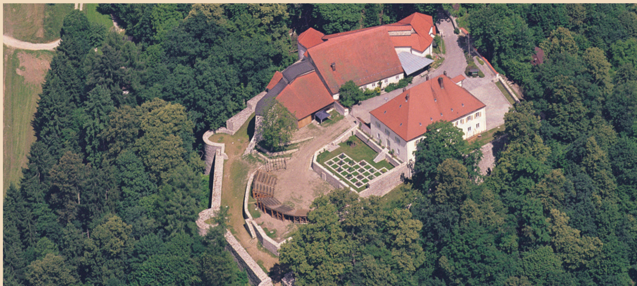
Luftbild Burganlage, Brücke oben rechts, Pflegerhaus mitte rechts (H. Stenzel)
