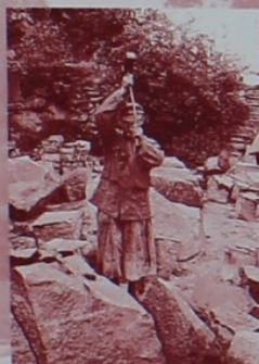
beim Spalten eines Blocks
