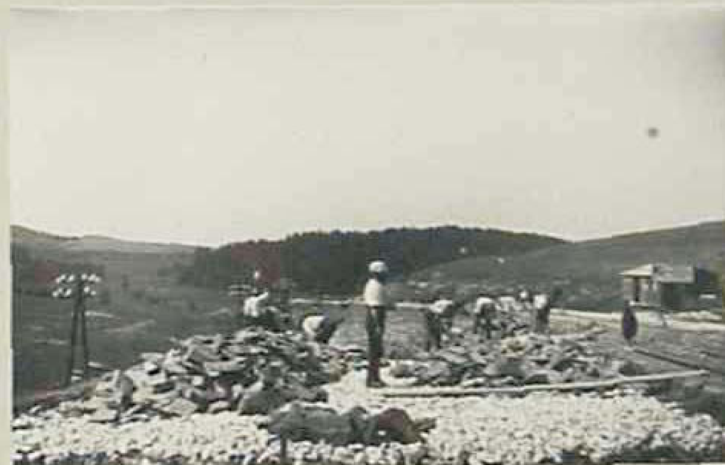
Straßenbauarbeiten an der „Reichsstraße 11“ zwischen Reinhardtsmais und Regen, 1935
